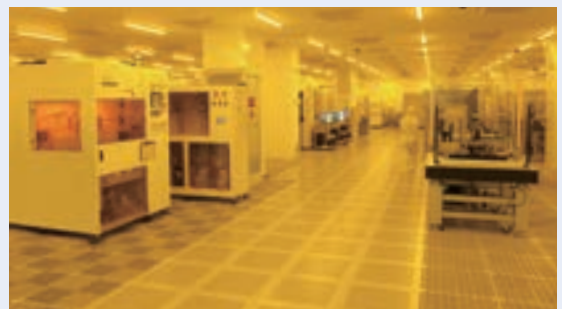
MEMS製造(クリーンルーム)
